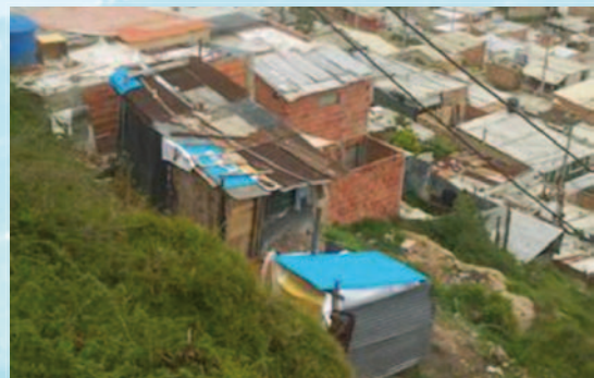
Sistema flauta de donde toma el agua del Tanque de Sierra Morena el barrio Caracolí y barrios de Soacha
